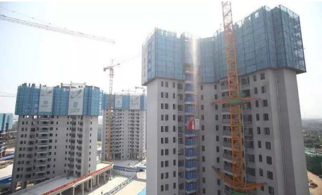
碧桂园SSGF项目工地
